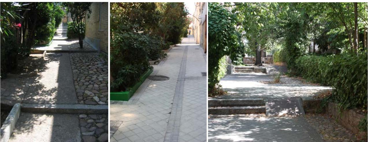
Figuras 22, 23 y 24: estado original y reformado de la pavimentación, con la inclusión de rampas
